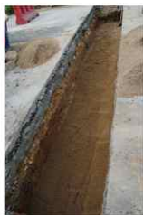
2: 开挖地面、填平
